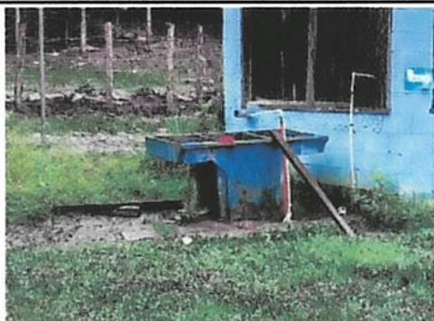
FOTO 3: PILA EN MAL ESTADO, NO TIENE CONDUCCIÓN DE AGUA DE DRENAJE Y LAS INSTALACIONES DE SERVICIO DE AGUA NO SIRVEN
